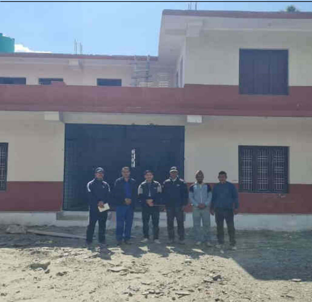
१ नं. वडा कार्यालय भवन निर्माण कार्य सम्पन्न
